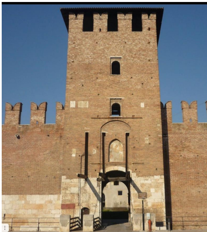
Рис. 7. Вид на вход в замок Кастельвеккио (XIV в.) в Вероне, Италия Fig. 7. View of the entrance to the Castelvecchio castle (XIV century) in Verona, Italy
